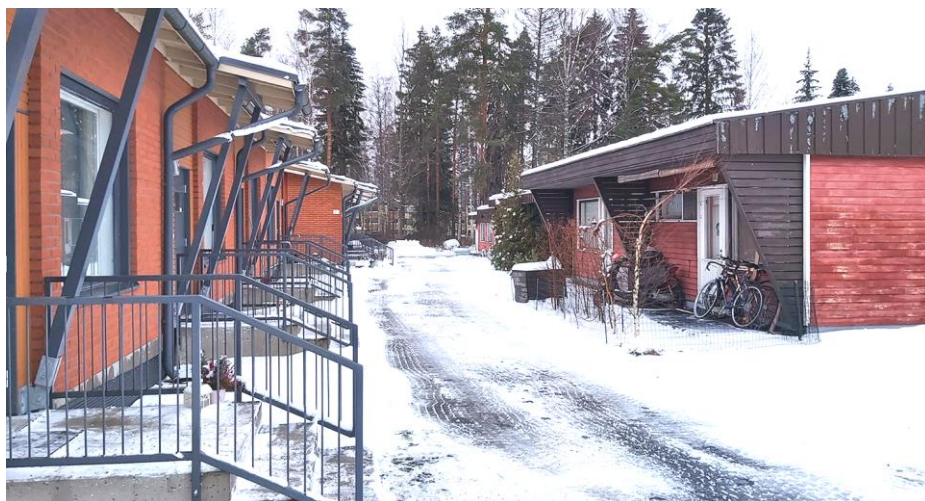
Kuva. Näkymä korttelialueen keskiosasta länteen, vasemmalla säilytettäviä uusia rivitaloja ja oikealla purettavia, joiden paikalle tavoitellaan uudisrakentamista
